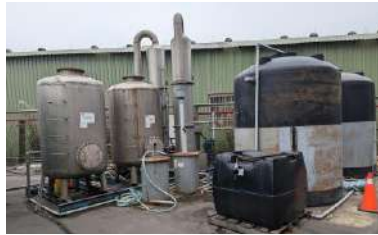
圖 27 東陽實業觀音廠場址整治作業執行情形
