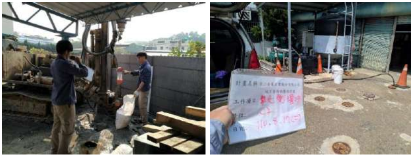
圖 35 景二公司場址整治作業執行情形
