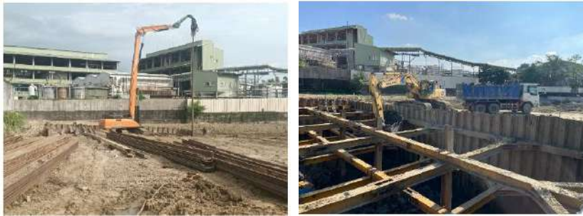
圖 31 那拔段場址整治作業執行情況
