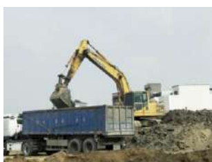
污染土壤裝載離場
