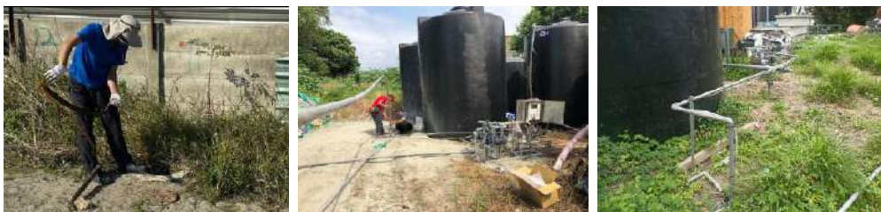
圖 41 山子坪小段場址整治作業執行情形
