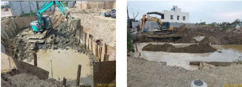
圖 39 育昇加油站整治區域執行情況
