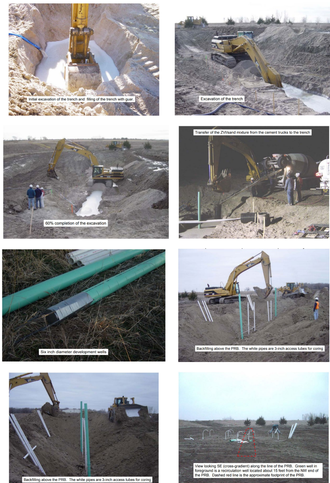
圖 5.2-6 現場作業照片
