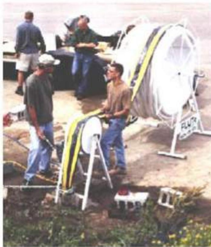
圖 1.4.6-4 充脹式視管設置現場照片圖
