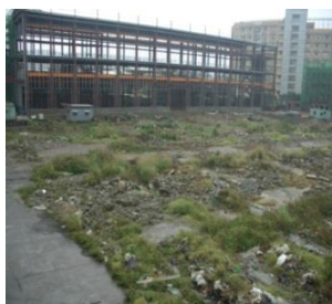
廠房現已全部拆除
