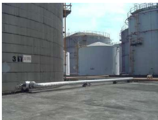
(a) 地上型儲槽外觀
