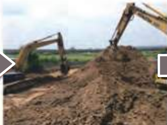
步驟 5: 挖土機進行水平稀釋
