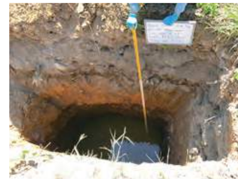
▲土壤開挖坑調查
