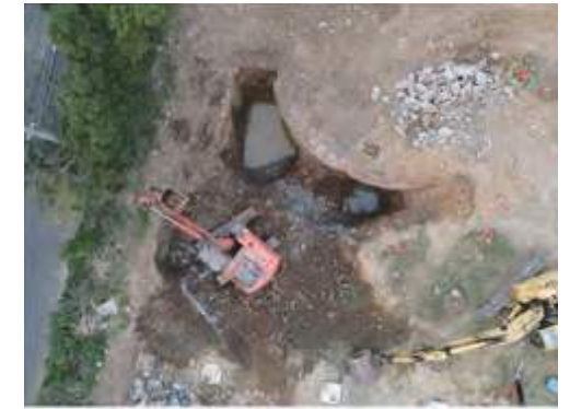
▲土壤調查現場施作鳥瞰圖
