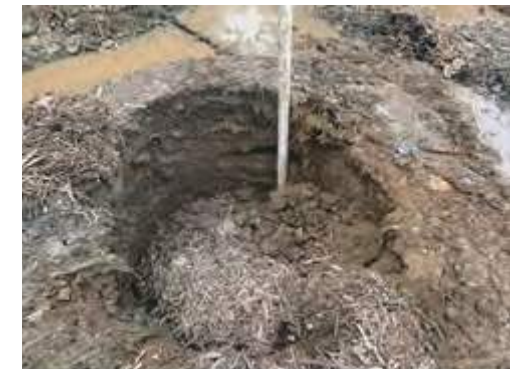
▲生物鑽井井管設置
