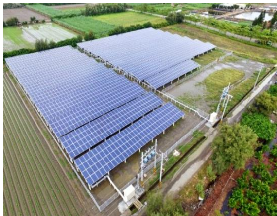
雲林最大地面型-台西地層下陷不利農業經營區1.6MW
