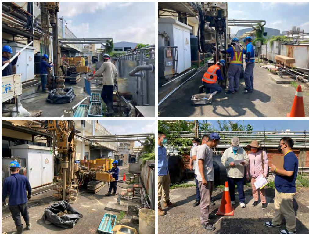
圖 4.2.3-16 統懋半導體股份有限公司新市總廠整治作業執行情形
