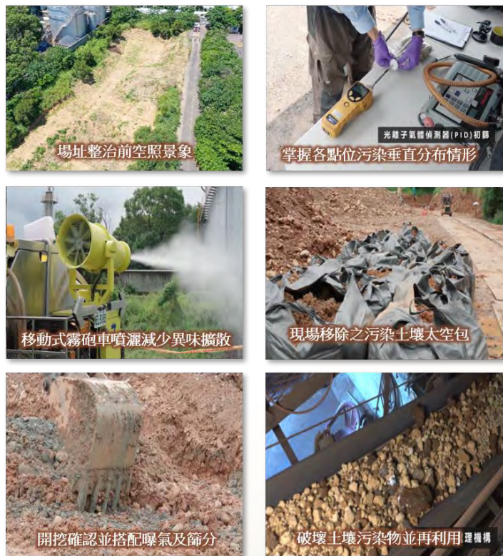
圖 4.5-2 南投縣大崗段場址補充調查與整治作業
