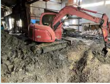
污染土壤開挖作業情形
