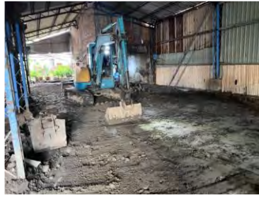
客土回填作業
