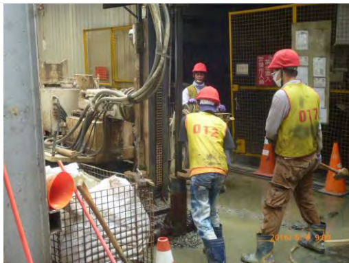
設立抽除處理井
