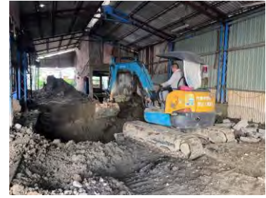
翻土稀釋作業情形
