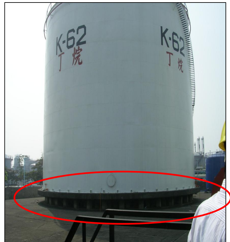
儲槽預防工程設施-懸空(2)
